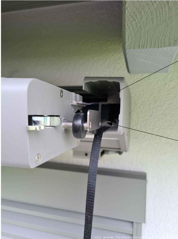
Die Rollen des Schlittens haben relativ viel Spiel. Deshalb ist es wichtig, dass die Rollen beim Einführen der Führungsschienen in diese Bahn eingeführt werden. Bitte darauf achten, daß beide Rollen korrekt eingeführt wurden.
